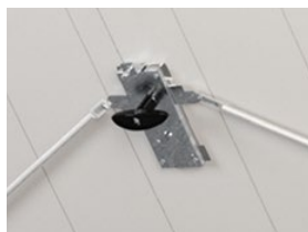
Zamek z wkładką ryglującą bramę dwustronnie
