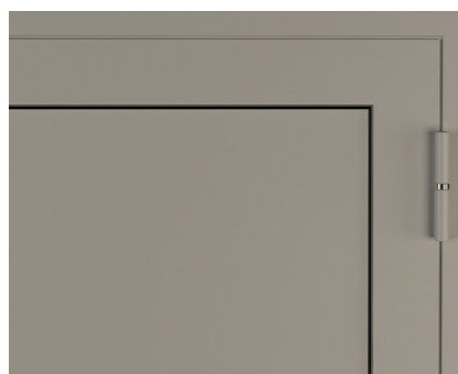
Rys. 5. Zawiasy spawane do konstrukcji ościeżnicy i skrzydła
