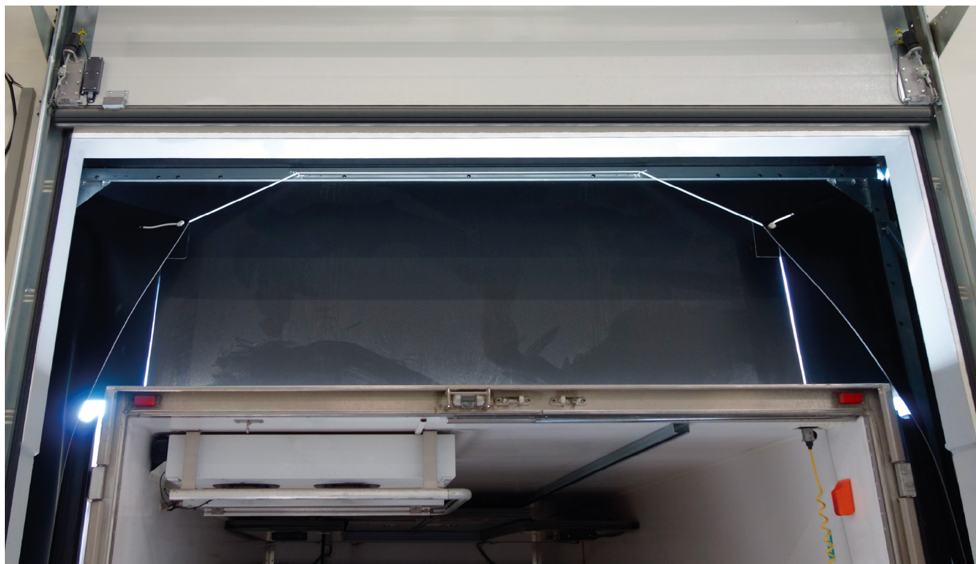
Składana kurtyna (śluza) uszczelniająca ABRE – widok od wewnątrz.
