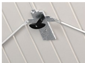
Serratura con il cilindro di chiusura bilaterale
