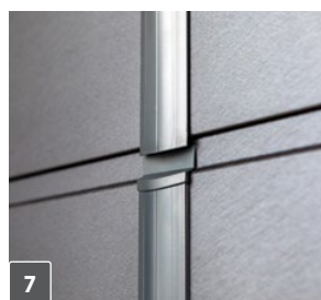
Embouts d'une forme sûre, garantissant l'étanchéité
