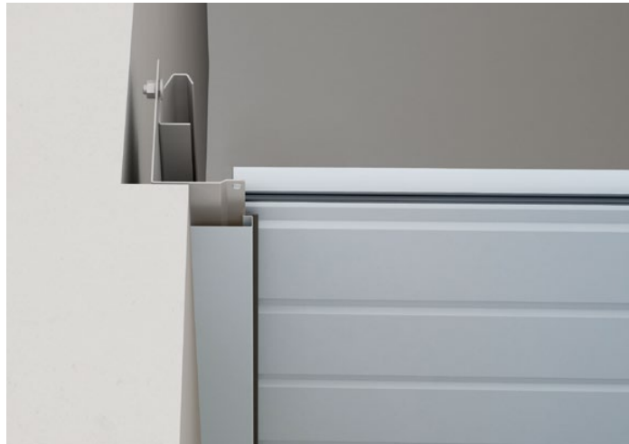
Pose derrière la baie - cache derrière la baie
