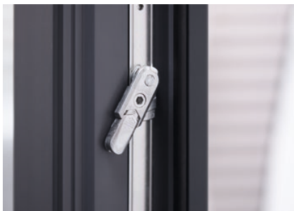
Zámek s blokádou otočení kliky a zvedacem křídla
