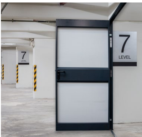
Interiérová strana křídla
