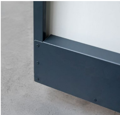
Untere Verstärkung des Türflügels
