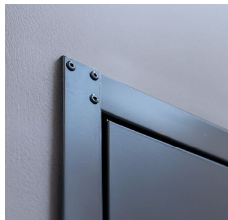
Assemblages du bâti rivetés
